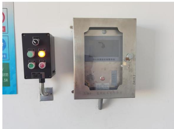
110kV GIS 室内 SF<sub>6</sub> 报警装置
